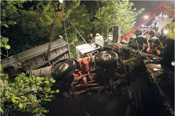
Bild 1: Einsatz eines Kranfahrzeuges zur Verhinderung des weiteren Abbrutschens (Foto: Hermann Kollinger)
